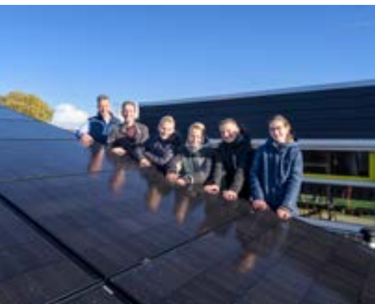
^ Met leerlingen bij de zonnepanelen van de School met de Bijbel
